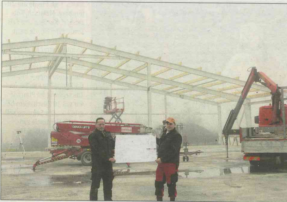
Erwin (links) und Jürgen Aigner zeigen den Bauplan für ihr neues Werk, das derzeit auf dem Gelände der ehemaligen Fleischerei Kocourek am östlichen Ortsrand von Gars in Richtung Mörtersdorf entsteht.
